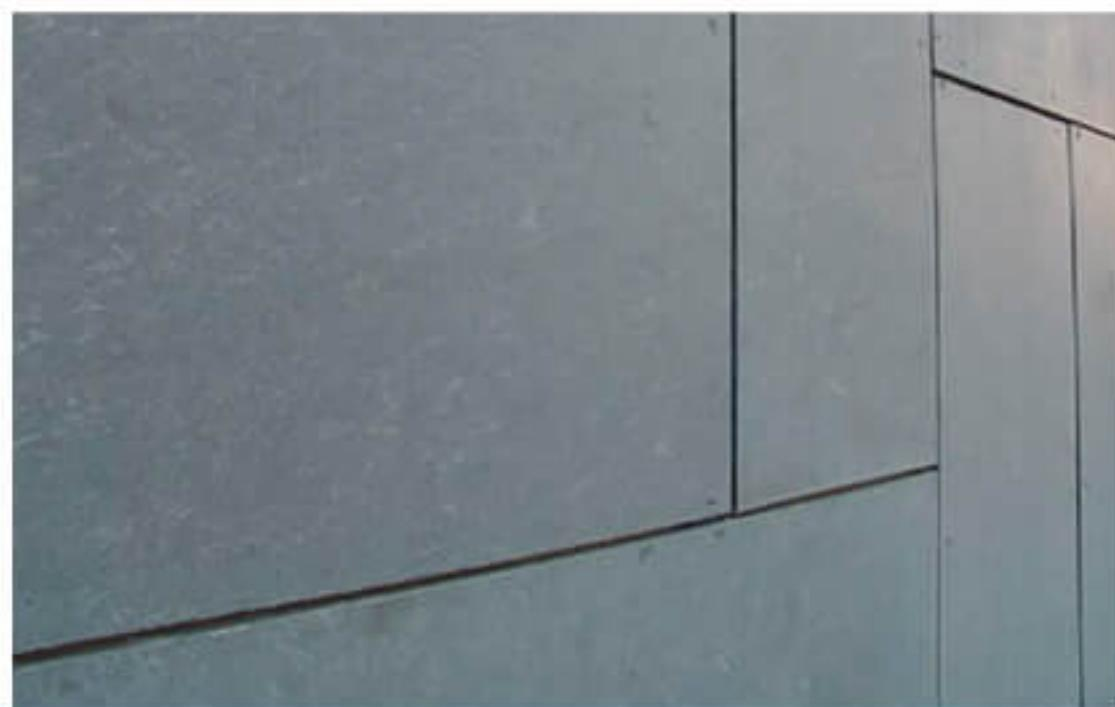
ورق های فایبر سمنت ایران برد به صورت ساده و خام در ضخامت 4 میلیمتر تا 18 میلیمتر تولید میشود و هر کدام بنا به ضخامت مختلف در هر یک از اجزا کاربرد دارد.
